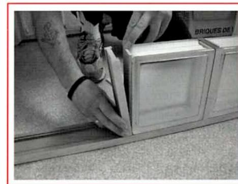
Installer la première rangée de briques avec les clés, y compris entre l'encadrement et les briques d'extrémité. Intercaler un profil court entre les briques.
