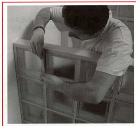
Montage simple et rapide de briques de verre, avec encadrement et joints bois.
