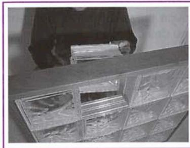
Insérer les briques entre le profil long et l'encadrement et positionner ensuite les profils courts entre les briques en allant d'une extrémité à l'autre.
