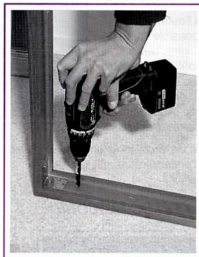
Vissez l'encadrement au gros oeuvre. S'assurer à l'aide d'un niveau que le cadre est parfaitement positionné.
