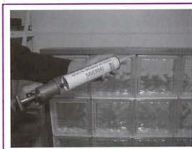
Appliquer le silicone dans les joints entre les briques sur les deux faces du panneau.
