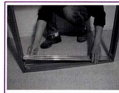
Poser un profil long horizontalement sur la partie basse de l'encadrement et un profil court verticalement.
