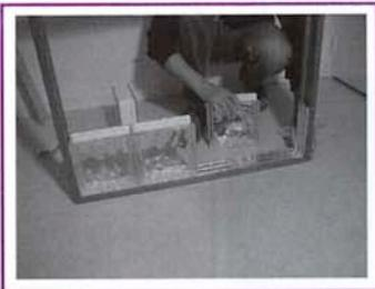
Ne pas oublier à chaque rangée d'insérer un profil court entre les briques d'extrémité et les montants verticaux de l'encadrement.
