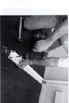
Positionner les chevilles près des équerres et s'assurer à l'aide d'un niveau que le cadre est parfaitement positionné.
