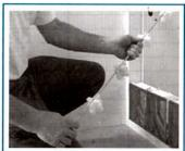
11 - Pour finir, appliquer un mortier de finition et lisser les joints à l'éponge
