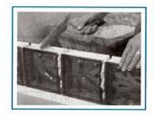
6 - Installer une rangée de briques en s'assurant de la bonne assise de chaque brique et mettre en place le mortier à la truelle dans les joints verticaux, y compris les joints d'extrémité.
