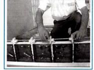
8 - Mettre en place l'armature équipée des croisillons droits et des croisillons d'extrémité de part et d'autre, à chaque rangée
