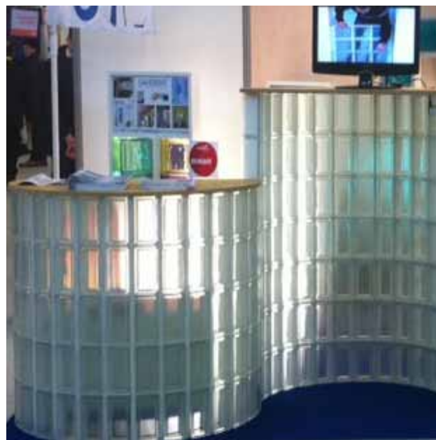
Panneau réalisé avec des briques 19x9 cm
